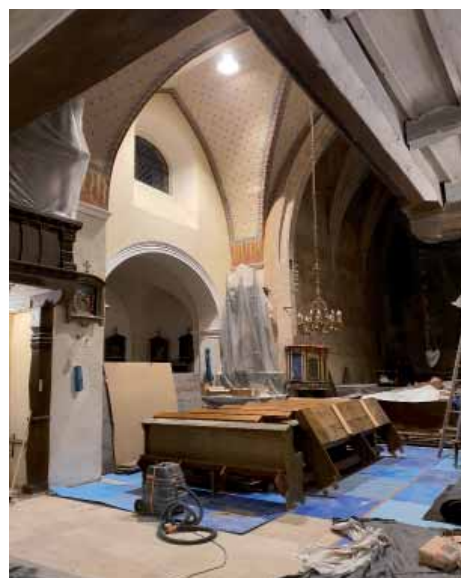
Výměna dlažby v kostele Narození Panny Marie ve Starém Plzenci Foto: Josef Švéda
